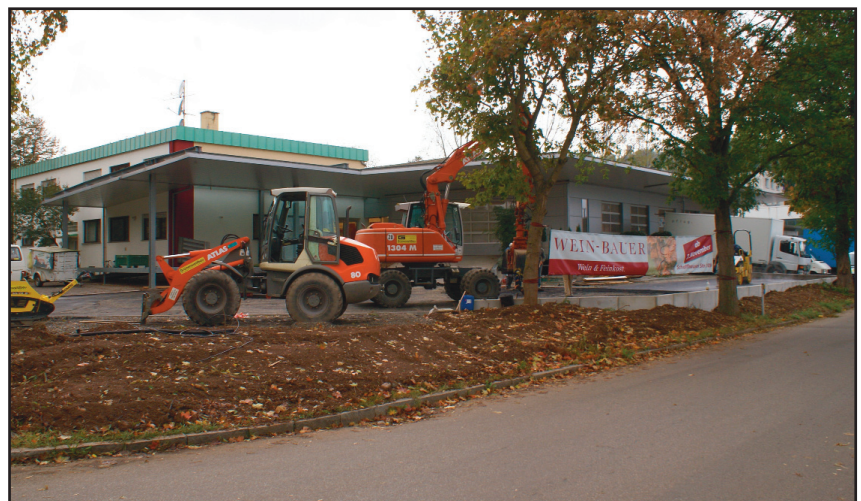
Wir schaffen das: Die Baustelle am 13.10.2009
